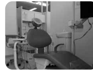
プライバシーに配慮された診察室
